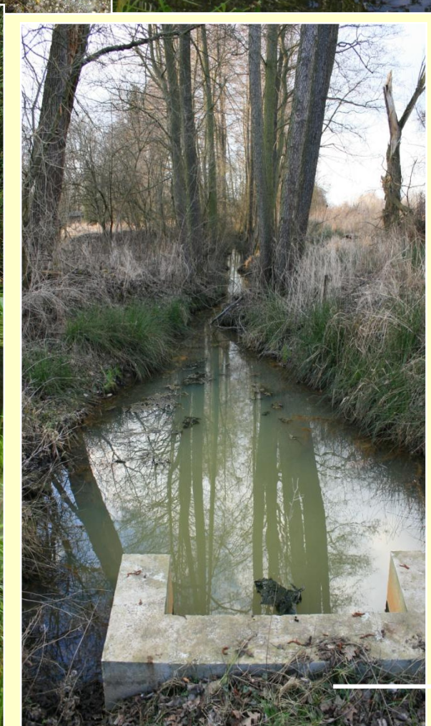
Odkalovací zařízení na Střibném rybníku zaústěné do PCHP
